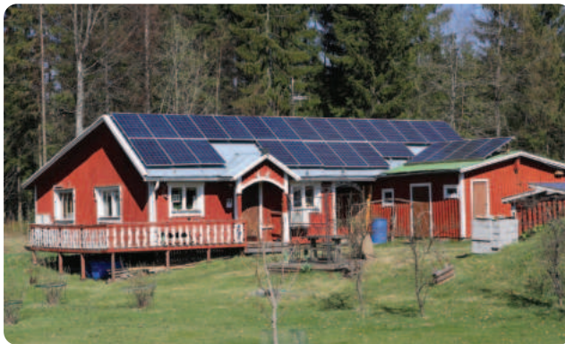
Gambar 7.6 Panel surya di atap rumah.
